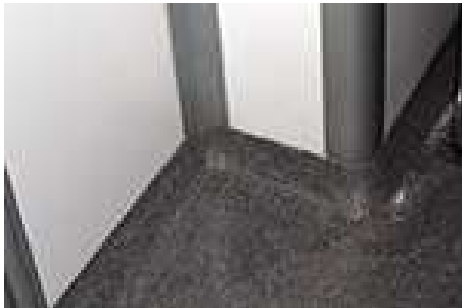
PERFILES SANITARIOS EN JUNTAS PARED-SUELO
